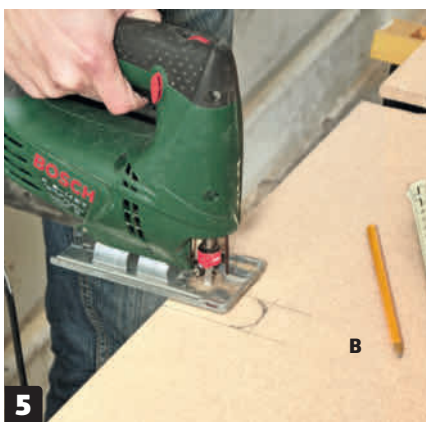
5 Skjær ut til lodrette rør. Hold opp bunnplaten (B), og tegn opp hvor det skal skjæres ut til lodrette rørstykker. Skjær ut hullene med en stikksag.
