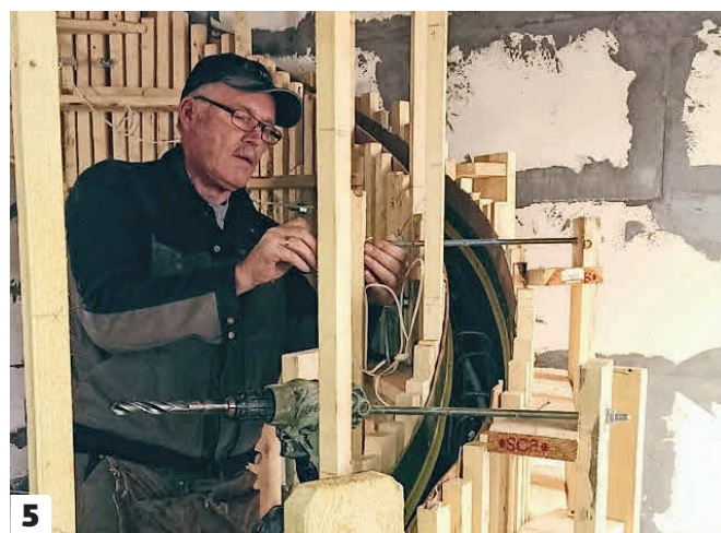
5 De lodräta reglarna på båda sidor om gjutformen spänns fast med långa skruvar och muttrar. Trycket på formen blir stort när den fylls med betong, så den måste vara stark!
