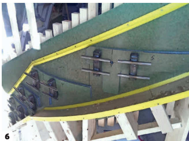
6 För varje steg gjuts ett specialbyggt beslag in i vangen. Det ser till att det svävande steget kan fästas i vangen och att steget sitter fast ordentligt.
