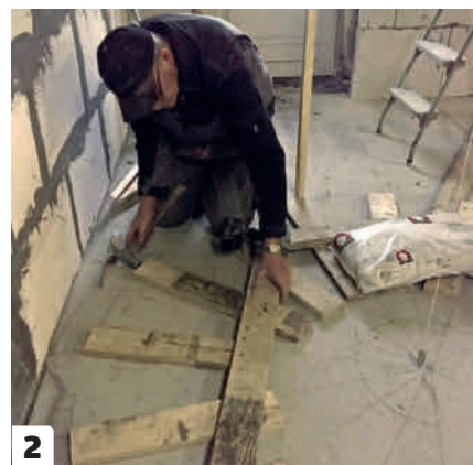
2 Gjutformen till vangen byggs av trä efter markeringarna på golvet. Vangens böjning markeras med brädor på golvet, så att det vid änden av dessa kan ställas de lodräta regler som gjutformen byggs av.
