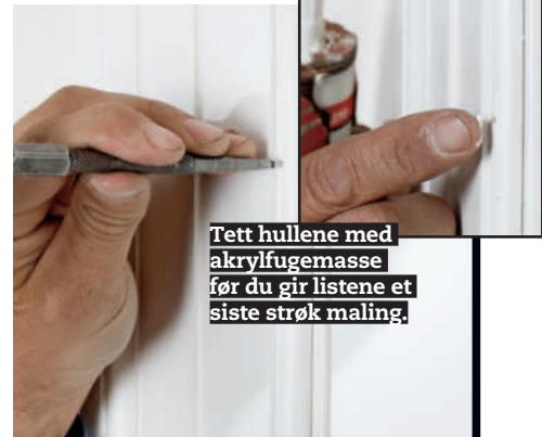
**5 Dykkertspikrene forsenkes 1 mm med en dor.** Har du ikke dor, kan du bruke en stor spiker eller en skrue. Hodet på dykkertspikrene dekkes med litt hvit akrylfugemasse.
