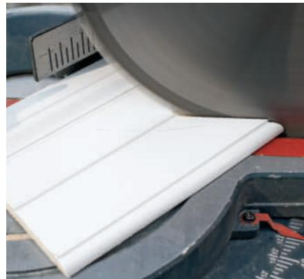
**3 Sag til listene øverst med et snitt på 45 grader.** Det er en stor fordel å bruke ei kapp-/gjærsag fordi den lager det peneste snittet. Har du ikke ei slik sag, kan du prøve å få låne eller leie – spesielt hvis du skal sette lister på flere dører.
