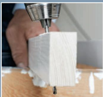
**1. Bor opp med et 4 mm bor i utføringa. Bor fra forsiden – litt skrått for å få skruen til å sitte i bakkanten av utføringa slik at karmlista kommer til å dekke skruen.**
