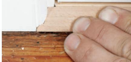
**2 Merk opp, og skjær til feielista med en skarp hobbykniv** slik at den passer omrent til profilene. Bruk en skarp hobbykniv, og pass på fingrene. Sjekk jevnlig slik at du ikke kommer til å skjære av for mye.
