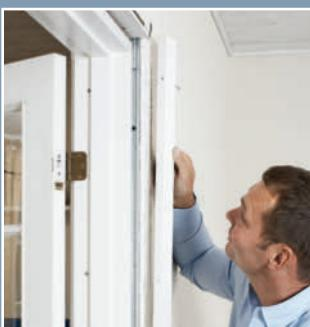
**2. Sett fast lista med 4 x 70 mm treskruer med 40–50 cm avstand. Legg på hvitt trelim på baksiden av lista slik at den ikke sprekker i sammenføyningen før du setter den opp.**
