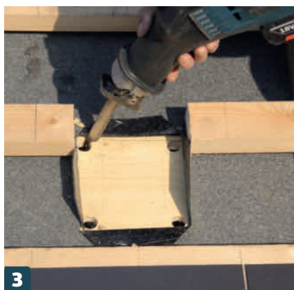
3 Taita huovan reunat ylös ja poraa reiät aluskatelevyn nurkkiin isolla puuterällä. Sahaa sen jälkeen aluskatelevyyn reikä puukkosahalla.
