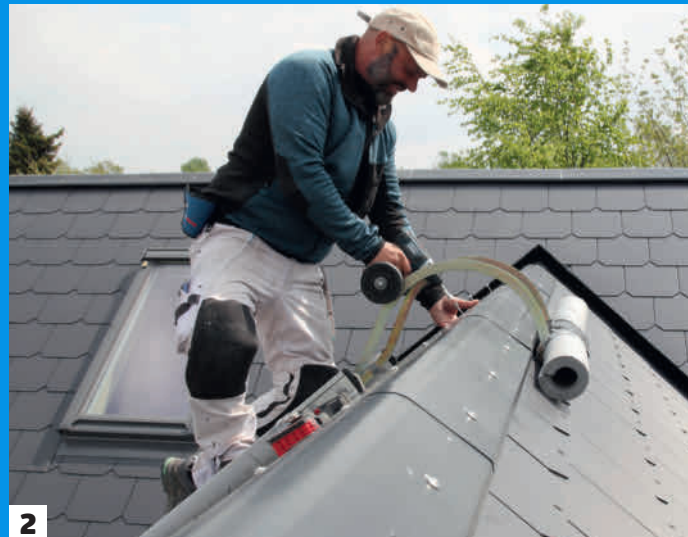
4 Asenna taivutettu alumiinilevyn palanen putken päälle samalla tavalla kuin kattoikkunan päälle. Asenna kouru 2–3 senttiä kallelleen ja liimaa se kiinni huopaan kumbitumiliimalla.
