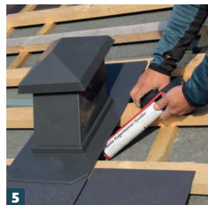
5 Asenna läpivienti paikalleen ja tiivistä putken reunat. Paina sen jälkeen huovan reunat läpivientä vasten. Tämä läpivienti naulataan kiinni samalla tavalla kuin katon liuskekivet.
