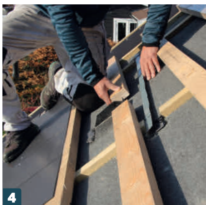
4 Asenna taivutettu alumiinilevyn palanen putken päälle samalla tavalla kuin kattoikkunan päälle. Asenna kouru 2–3 senttiä kallelleen ja liimaa se kiinni huopaan kumbitumiliimalla.
