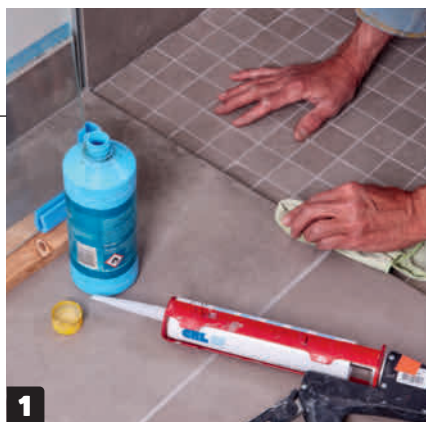
1 Gulvet affedtes meget grundigt med sprit og en ren klud.
