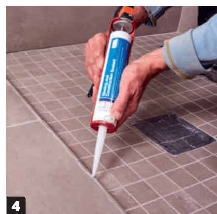
4 Læg en smal stribe silikone på gulvfliserne, der hvor skinnen om lidt skal fastgøres. Vi ønsker ikke at bore huller i gulvet, dels fordi det ikke er nødvendigt, dels fordi vi har gulvvarme under fliserne.
