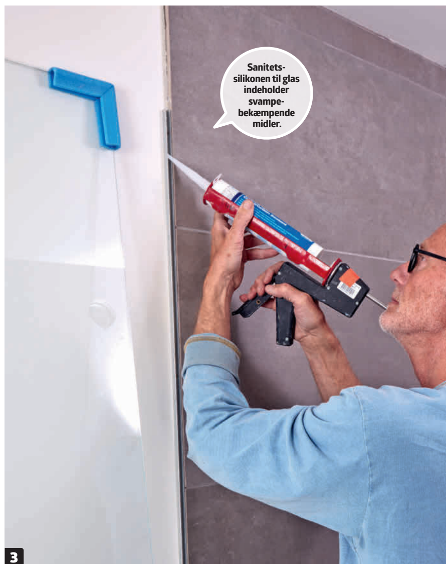
Læg derefter en stribe klar specialsilikone i bunden af U-profilet. Silikonen er netop beregnet til montering af glas.
