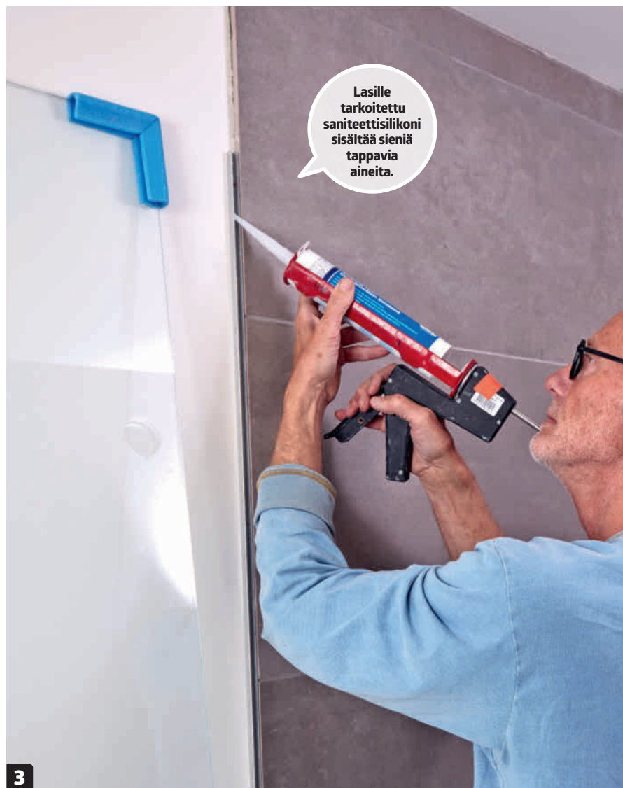
3 Levitä kirkasta erikoissilikonin kiskon pohjalle. Silikonin on tarkoitettu lasin asentamiseen.
