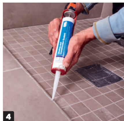
4 Levitä laatoille kapea noro silikonin lasin asennuskohtaan. Lattiaan ei haluta porata reikiä, koska se ei ole pakollista ja laattojen alla on lattialämmitys.
