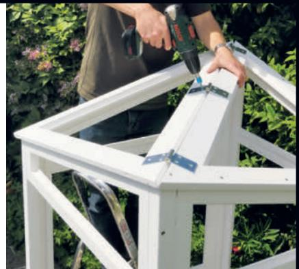
**3 Legg på plass takrammene**, og skru den faste delen til siderammene med 4 x 50 mm skruer. Hengsle den andre rammen på den fastskrudde rammen.
