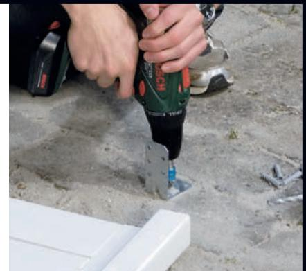
**2** Plasser fire vinkelbeslag slik at de festes på innersiden av hver side. Er du usikker på plasseringen, kan du skru dem fast etter at du har satt opp sidene.
