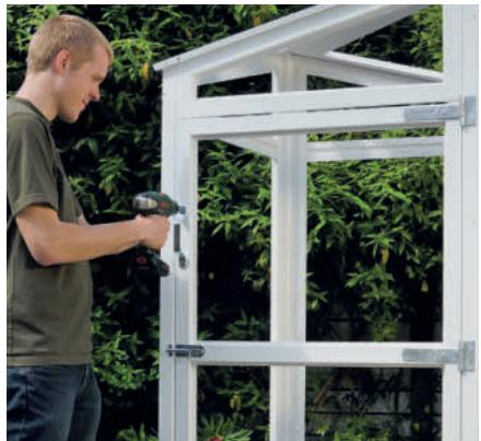
**4 Skru hengslene** på hjørnestolpen, kil døren på plass og skru fast hengslene på døren. Monter deretter håndtak og en skåte.
