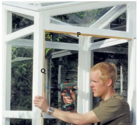
**7 Skru de tre falslistene (P og Q) til døren**, på den fremste rammen med 4 x 20 mm skruer. Falslistene forhindrer at døren slår inn i selve drivhuset.
