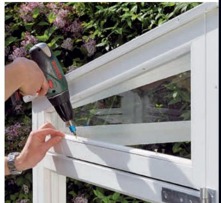
**6 Spikre eller skru på glasslistene (N).** Her er det brukt 4 x 20 millimeter skruer, som skrus ned i rammene uten å skade selve glasset.
