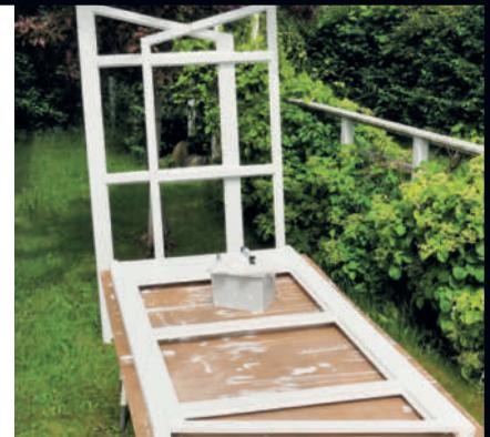
**3** Så skal alle delene males. Én gang med grunning og to ganger med dekkmalning er det optimale. Malingen må være beregnet for utendørs bruk.
