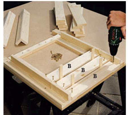
**6** Legg sideborda (B) på plass, og skru dem fast på beina (A + D) med 4,0 x 35 mm skruer. Bruk en cm tykke lister for å holde den samme avstanden mellom listene.
