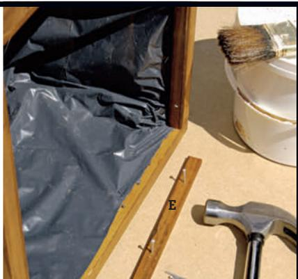
**4** Før blomsterkassa får et strøk trebeskyttelse, bør du gi den et grunningsmiddel mot råte og sopp. Til slutt spikrer du på dekklistene (E og F) med 12 x 25 mm galvanisert spiker.
