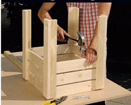
**1** Klipp til et stykke netting med ei metallsaks (du kan også bruke en vinkelsliper – bruk vernebriller og -hansker), og fest den under sidebordene med 1,6 x 15 mm kramper.
