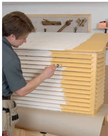
Pohjamaalin päälle sivellään öljymaali. Öljymaalikerroksia tarvitaan vähintään kaksi.
