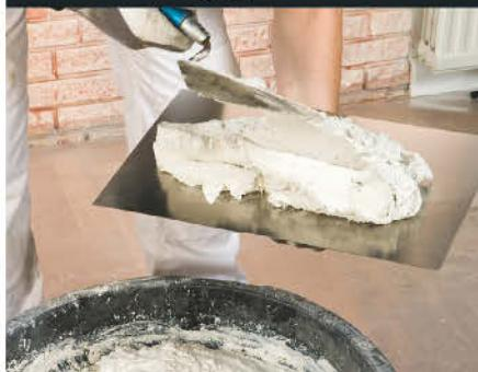
**1** Rør opp en porsjon gipspuss, og trekk den på med et stort stålrett. Gipspussen skal ha konsistens som krem. Bland bare så mye som du rekker å bruke på en halv time. Pussen legges på stålrettet med ei spanskje.
