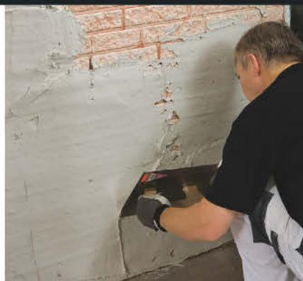
**2** Begynn nedenfra i et hjørne når pussen trekkes på. Når du har fylt et område loddrett, fyller du etter i en vannrett bevegelse. En mursteinsvegg med fuger som er skrapet ut, sluker mye puss så du kommer ikke langt med ett brett.
