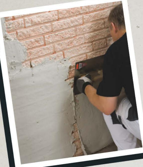
Til en mursteinsvegg med dype fuger duger ikke vanlig sparkelmasse. Veggens skal pusses. Og her er gipspussen praktisk fordi den kan trekkes på i centimeter tykke lag.
