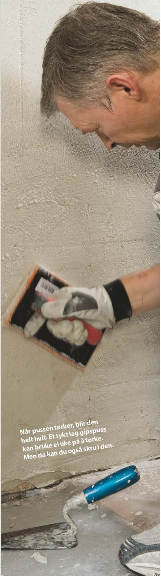
Når pussens tørker, blir den helt hvit. Et tykt lag gipspuss kan bruke ei uke på å tørke. Men da kan du også skru i den.
