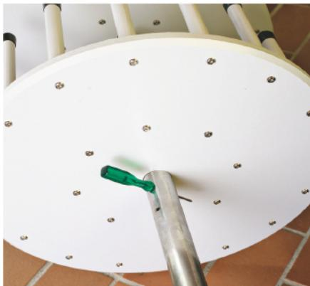
**3** Når alle de store skivene er dyttet på plass, låses plasseringen midlertidig med en skrutrekker gjennom hullene i stålstanga. Når skivene er løftet på denne måten, er det plass til å montere den nederste skiva.
