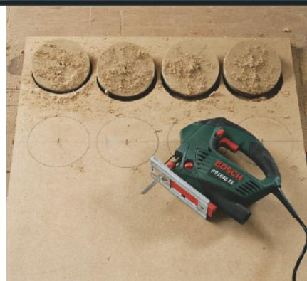
**1** Tegn opp de runde skivene på ei mdf-plate med en passer. Pass på at sentrum er tydelig markert, og at sirkelen er oppdelt i fire like store stykker før du skjærer dem ut med ei stiksag. Slip kantene etterpå.
