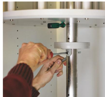
**5** Nå er tiden inne for å feste de store skivene i riktig høyde. En 6 x 60 mm maskinskrue med sprengskive dyrtes gjennom vinkeljerna og stålstanga, og mutteren trekkes til.
