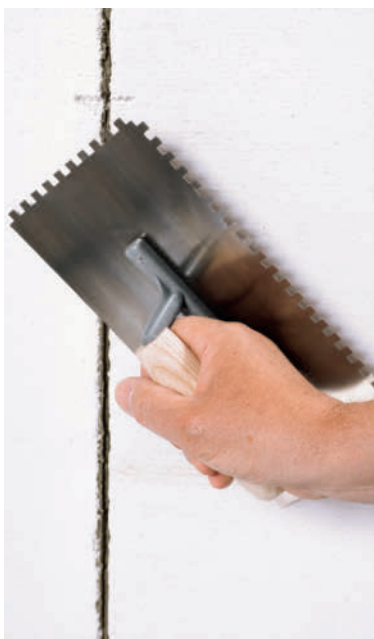
Her skal vi sette opp fliser på elementer av porebetong. Først skrapes underlaget ved hjelp av flis-sparkelen slik at flata blir helt jevn.
