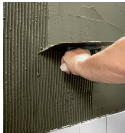
Når limet er lagt på, trekkes det gjennom med tannsparkelen. Trekk nedenfra og opp. Hold sparkelen nesten vannrett.
