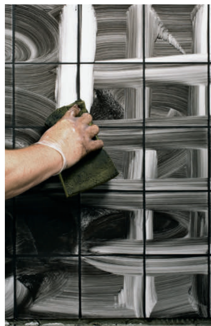
Det ser fælt ut når vi fuger med svart for effektens skyld, men fugemassen kan lett vaskes av flisene igjen.
