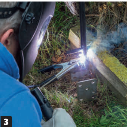
3 Hitsaa kaari kiinni maassa oleviin rautoihin, jotta se pysyy tukevasti paikallaan. Siisti sauma, anna sen jäähtyä ja maalaa se ruosteenestomaalilla.
