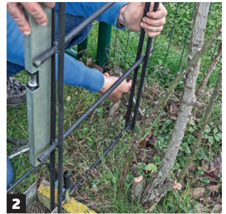
2 Aseta ruusukaari maassa olevien rautojen kohdalle ja tarkista vatupassilla, että kaari on suorassa. Kun ruusukaari on suorassa, kiinnitä se puristimilla, jotta voit hitsata kaaren kiinni.
