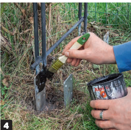
4 Maalaa koko ruusukaari ruosteenestomaalilla. Levitä maalia myös maassa oleviin kiinnitysrautoihin.
