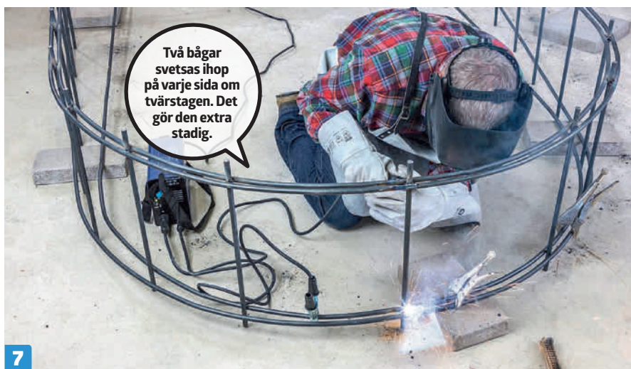
7 Svetsa fast tvärstagen vid en båge på motsatta sidan. På båda sidor svetsas också fast en båge på insidan av tvärlåarna, så att det i praktiken blir en dubbelbåge.
