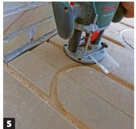
5 Väliseinän vieressä ei ole kääntymisuraa kuten ulkoseinustoilla. Voit tehdä sen itse yläjyrsimellä. Käytä teränä urajyrsintä.
