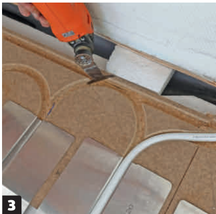
3 Letkuille pitää tehdä reiät paikkoihin, joista ne vedetään levyihin tai levyistä ulos. Reiät on helpointa sahata monitoimityökalulla.
