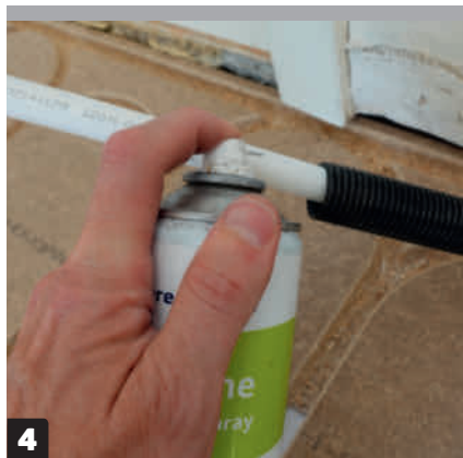
4 Letku liitetään lämmitysjärjestelmään suojaputkessa. Voit suihkuttaa letkun pinnalle silikonin, jotta se liukuu helpommin suojaputken sisään.
