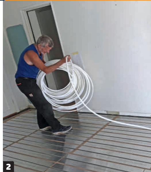
1 Paina letkut lämmönluovutuslevyjen uriin. Se on helpointa tehdä polkemalla.
