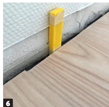
6 Sørg altid for at holde 1 cm's afstand til alle vægge. Når gulvet suger og afgiver fugt, kan det nemt ændre størrelse med flere millimeter.
