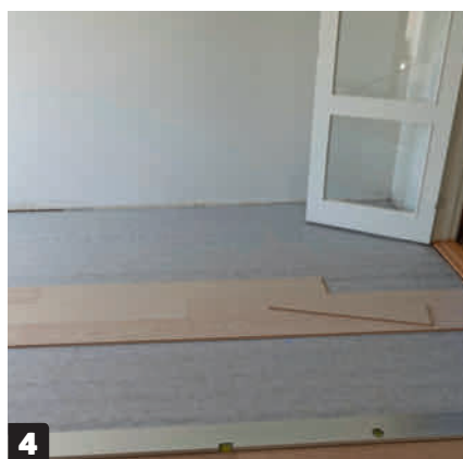
4 Start med en prøveoplægning. Klik en række brædder sammen, og læg dem op, så afstanden ind til væggen cirka passer med et helt antal brædder. Tjek, hvor lige eller skævt lokalet er, og ret ind, eller skær til.
