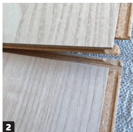
2 I enderne trykkes samlingerne sammen ved at presse feren i det øverste bræt ned i noten på det underste bræt.
