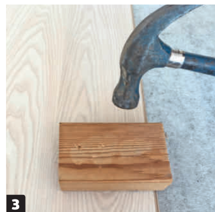
3 Hvis samlingerne ikke er helt plane, kan du slå dem sammen med en hammer og en klods, du lægger oven på gulvet.
