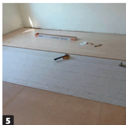
5 Nu kan gulvet skubbes ind til væggen, og så kan du komme videre. I de fleste tilfælde vil de inderste brædder være skåret til her – eller de vil blive det i den anden ende af rummet senere.
