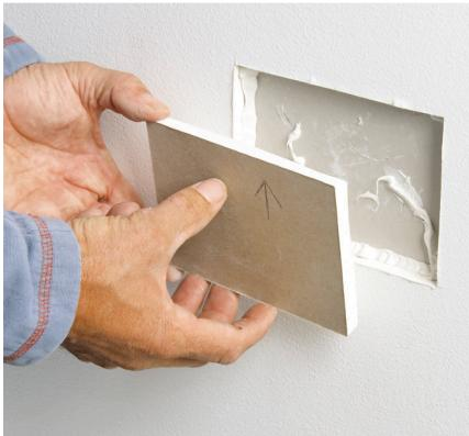
**5 Fest det nye stykket i hullet.** Smør først på et tynt lag gipsplatelim rundt kantene på hullet og på et par punkter midt på den innerste plata. Trykk så det nye gipsstykket forsiktig fast – til det er i plan med veggen.
