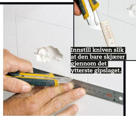
**2 Skjær vekk rektanglet med en hobbykniv.** Bruk helst en metallinjal slik at snittet blir helt nøyaktig. **TIPS:** Skjær alltid på hullsiden av linjalen. Glipper kniven, skjærer du da bare inn i det som likevel skal fjernes.
