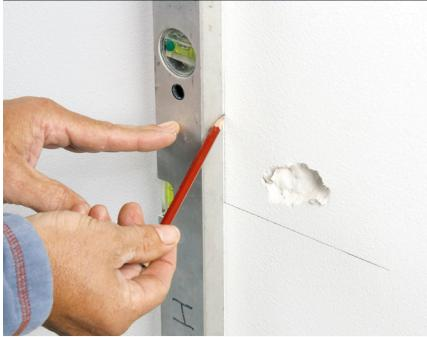
**1 Tegn opp en vinkelrett firkant rundt hullet,** for eksempel med et vater. Sjekk målene med en meterstokk slik at du er sikker på at firkanten du har tegnet er vinkelrett – det gjør det lettere for deg når du skal skjære til det nye stykket.
