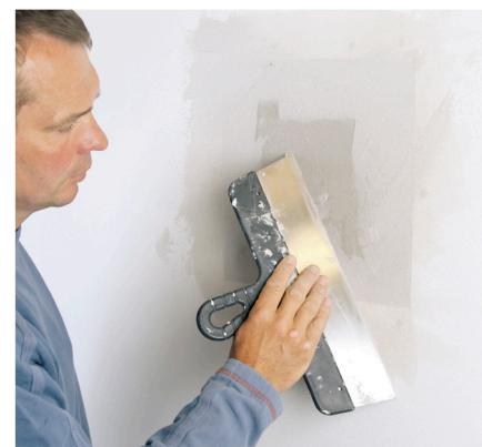
**5 Reparasjonen sparkles nå med sandsparkel.** Du skal sparkle og slipe minst to ganger for å være sikker på et pent resultat. Når du har slipt den siste gangen, rengjøres veggen, og den er klar til etterbehandling.
