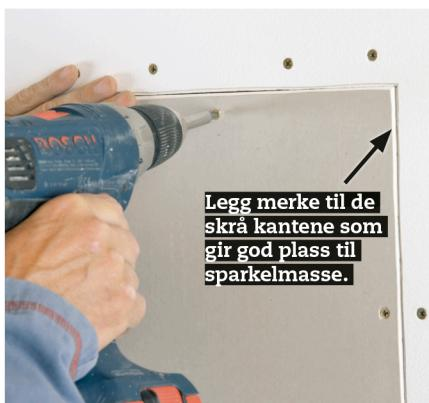
**4 Skru fast den nye gipsplata i hullet** med 3,5 x 32 mm gipsskruer til tre. Skruene plasseres med minimum 1 cm avstand til kanten. Du skal også lage en skrål kant på reparasjonsplata slik at sparkelmassen kan få godt feste.
