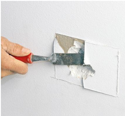
**3 Fjern det ytterste gipslaget.** Bruk et gammelt hoggjern – helst ett som er bredt. Pass på at du ikke ødelegger det innerste gipslaget. Det skal brukes som underlag for reparasjonen din.
