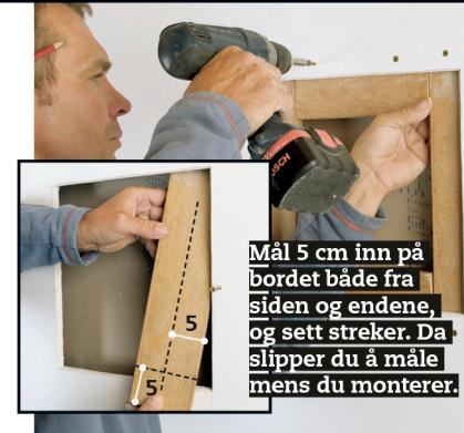
**1 Strek opp en vinkelrett firkant rundt hullet.** Sjekk målene med en meterstokk før du sager ut hullet med ei gammel håndsga. Pass på at du skjærer på den innvendige siden av streken slik at det blir så nøyaktig som mulig.
