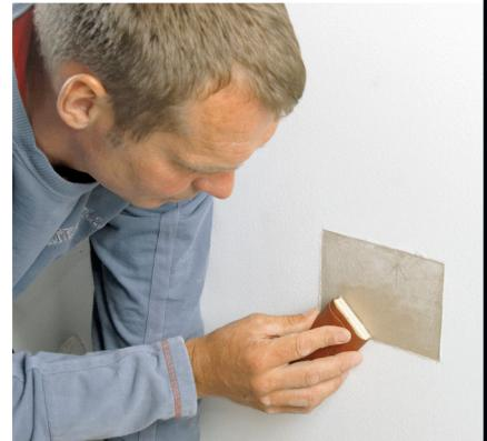
**6 Slip overgangen mellom det nye stykket og gipsveggen** når limet er tørt. Det tar ca. 6 timer. Bruk en slipekloss eller svært fint slipepapir, korn 180–240, og slip forsiktig.
