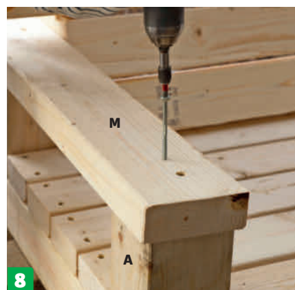
8 Armlænet (M) skrues fast med to lange skruer til hvert ben. Der er først boret for, og hullet er undersænket, så der er plads til skruhovedet. Armlænet er skåret til med et 15-graders snit, så det flugter ryglænet.
