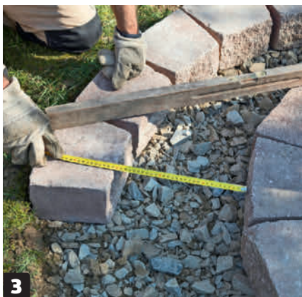
3 Tarkista mitat säännöllisesti. Varmista samalla, että kivet ovat vaakatasossa ja yhtä korkealla. Muuten seuraavat kerrokset kallistuvat.
