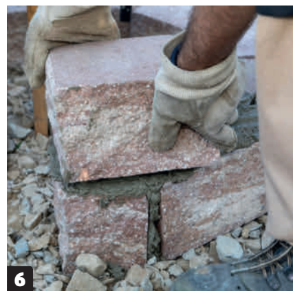
6 Asenna toisen kerroksen kivet limittäin alempien päälle. Paina kivet kunnolla kiinni laastiin, jotta saumoista tulee joka puolella yhtä paksut.
