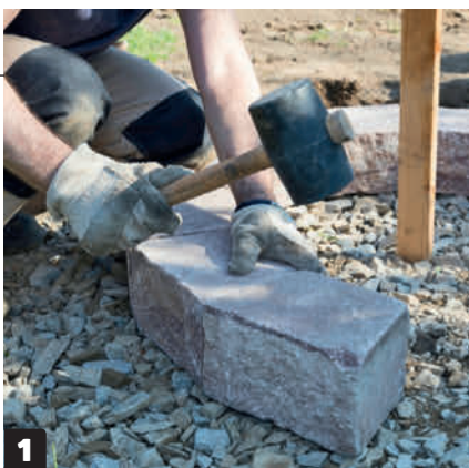
1 Slå på stenene med en gummihammer for at få dem lagt helt fast i gruset og rettet til, så de ligger i vater.
