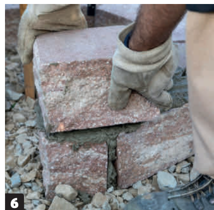
6 Læg stenene i andet lag i forbandt, så fugerne er forskudt fra lag til lag. Tryk stenen godt ned i mørtlen, så du opnår en ensartet fugetykkelse over det hele.
