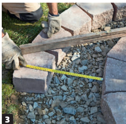
3 Tjek løbende målene. Sørg også for, at stenene ligger i vater og i samme niveau. Ellers kæntrer de næste etager.
