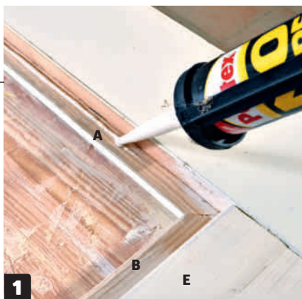
1 Påfør monteringslim på falslistene (A + B). Legg limet i en smal pølse – helt inn mot kanten av dørrammen.
