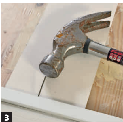
3 Spikre fast listene (A + B). Vær forsiktig, og legg en klut eller et pappstykke mellom glasset og hammeren.
