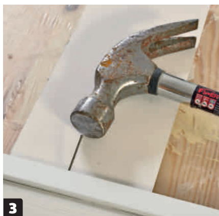
3 Søm listerne (A + B) fast. Vær forsigtig, og læg en klud eller et stykke karton mellem glas og hammer.
