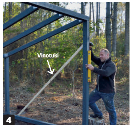
4 Asenna väliaikainen vinotuki, joka pitää rakenteen suorana seinien asentamiseen asti. Tarkista sitä ennen, että tolpat ovat suorassa.
