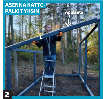
2 Ruuvaa palkin (E) päälle väliaikainen apulauta. Se pitää palkin paikallaan ruuvaamisen ajan.
