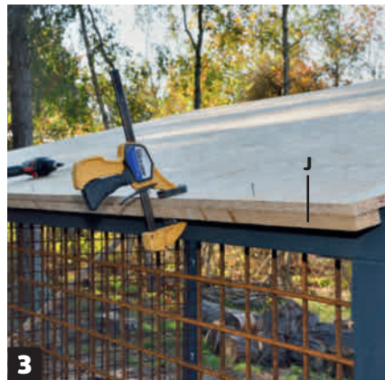
3 En bunnlist (J) monteres under takplaten langs baksiden. Listen, som takbelegget senere skal spikres fast til, skrues fast med 4 x 40 mm skruer.
