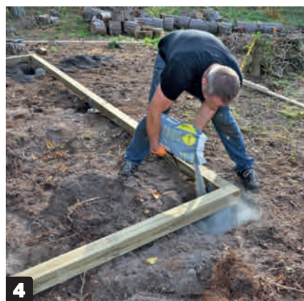
4 Tøm en halv pose tørrbetong i hvert hull når bunnsvillen er montert på fundamentene og alt står som det skal.
