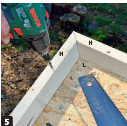
5 Skru fast trekantlistene (H) på oversiden av takplaten langs fronten og på sidene med 4 x 40 mm skruer. Den tilskårne flate siden skal vende opp, og den vinkelrette skal vende ut. Hjørnene skrånkjæres.
