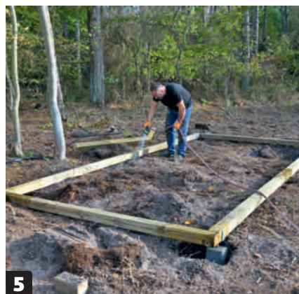
5 Hell rikelig med vann i hvert hull. Betongblandingen skal herde før du går videre. La den derfor stå natten over.
