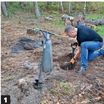
1 Grav ut til fundamentene med spade når du har målt opp plasseringen.
