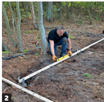
2 Plasser fundamentene slik at stolpeskoene flukter og er i vater. Det kontrolleres enklest med et vater i samarbeid med et langt, rett bord eller med en snor.
