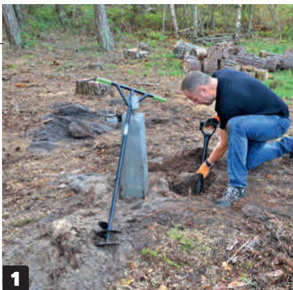
1 Grav ud til stolpestenene med spade og pælebor, når du har målt placeringen ud efter tegningen.
