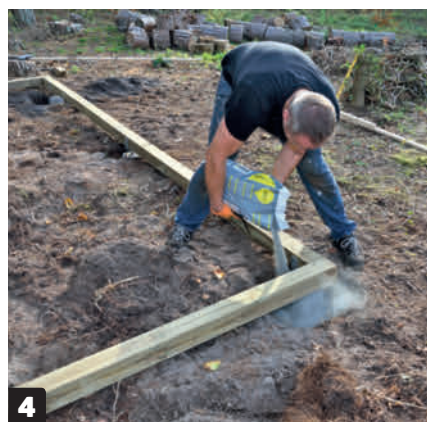
4 Hæld en halv pose beton i hvert hul, når bundremmen er monteret på stolpestenene, som står, som de skal.
