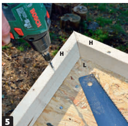
5 Skru trekantlisterne (H) fast på oversiden af tagpladen langs fronten og på siderne med 4 x 40 mm skruer. Den tilskårne flade skal vende op, og den vinkelrette flade skal vende ud. Samlingerne skæres i smig.
