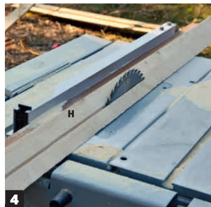
4 Skær ca. 1,5 cm af trekantlisterne (H), så den ene 45-gradersvinkel skæres fra. Det giver en blødere afslutning på tagpappet.
