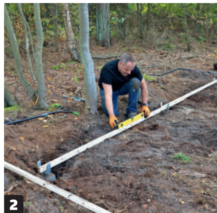
2 Placér stolpestenene, så stolpeskoene flugter og er i vater. Det kontrolleres nemmest med et vaterpas i samarbejde med et langt, lige bræt eller med en snor.
