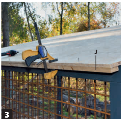
3 En bundliste (J) monteres under tagpladen langs skurets bagside. Listen, som tagpappet senere skal sømmes fast til, fastgøres med 4 x 40 mm skruer.
