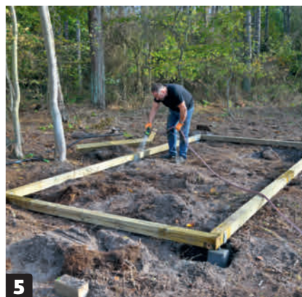
5 Hæld rigeligt med vand i hvert hul. Betonblandingen skal hærde, inden du går videre. Lad den derfor stå natten over.
