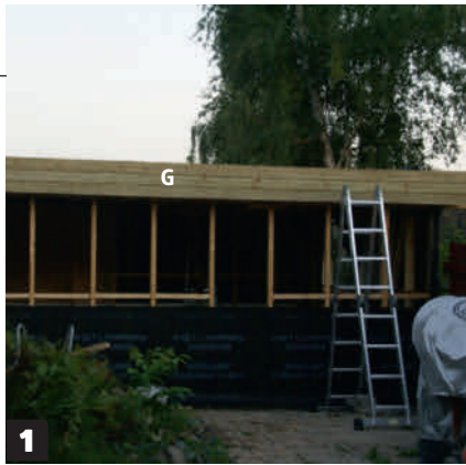
1 Sätt klädselbrädorna (G). De är tre stycken, som tillsammans effektivt skyddar fasaden och leder bort vattnet.
