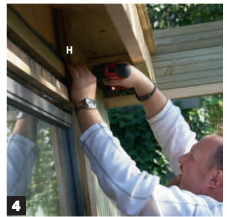
4 Vi låter klädselbrädorna (H) fortsätta över fönstret, även om takutsprånget skyddar mot regn och rusk. Det ger ett snyggt och enhetligt intryck.
