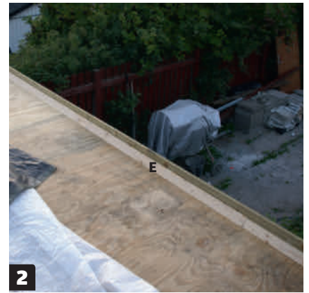
2 Vid takets kant sätts trekantsreglar (E). Reglarna skruvas fast och syftet med dem är att vara underlag för takpappen, som inte tål skarpa kanter.
