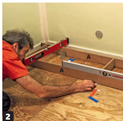
2 Kloss opp sokkelen vannrett med avstandsklosser for hver 60 cm, gjerne enda tettere. Vær flittig med vateret, for det er helt avgjørende at sokkelen blir rett.
