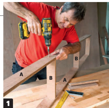
1 Sokkelen monteres. For- og bakstykket (A) skrues fast via mellomstykkene (B) med 5 x 60 mm skruer.
