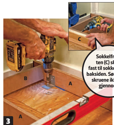
3 Sokkelen skrues fast til gulvet med møbelvinkler med passende skruer – korte i front- og baksiden, slik at de ikke går gjennom, og lengre skruer ned i gulvet.
