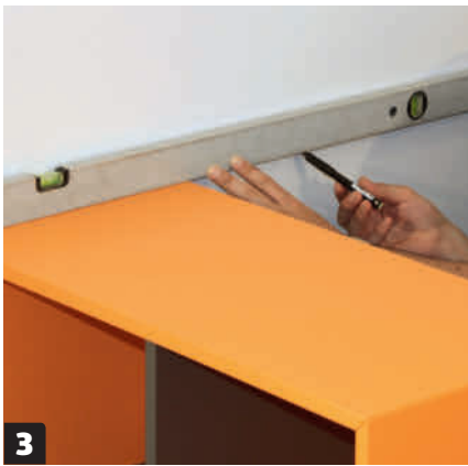
3 Piirrä yläreunan linja joka puolelle. Riman ja kaapin pinnan pitää olla samalla tasolla. Käytä piirtämiseen vatupassia.
