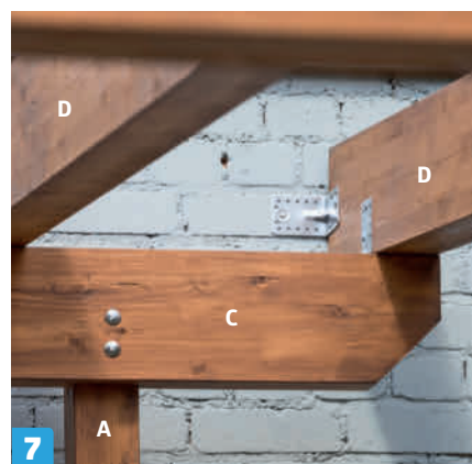
7 Varje spärr (D) fästs också i väggen med ett vinkelbeslag, så att överbyggnaden förankras ordentligt.
