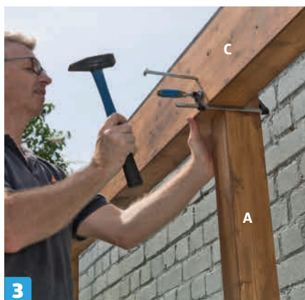
3 Fäst bärlinean (C) med långa bultar som bankas på plats genom förborrade hål. Bärlinean hålls på plats med tvingar tills bulten har skruvats fast på baksidan av bärlinean med bricka och mutter.
