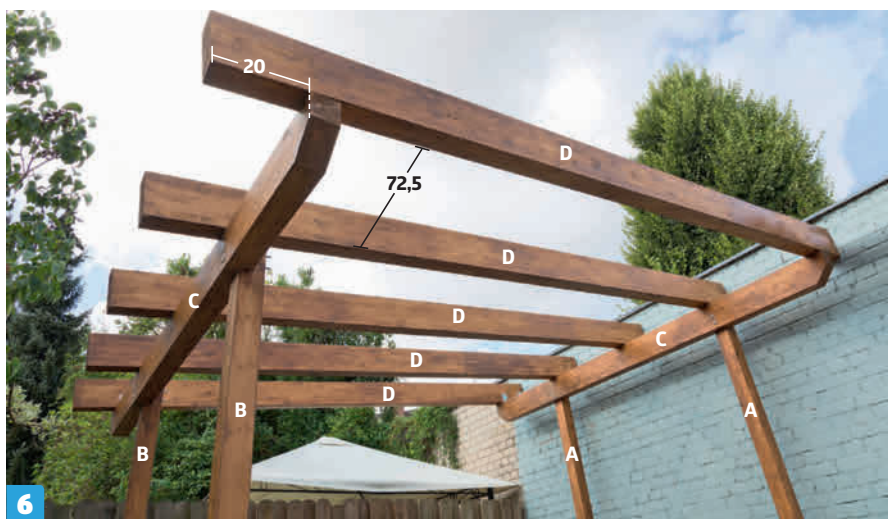
6 Alla spärrarna (D) är på plats. De har satts med ett avstånd på 72,5 cm och fästs med vinkelbeslag på båda sidor om varje spärr (D).
