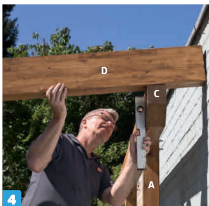
4 Sätt en tillfällig spärr (D) på bärlinean så att du kan kolla att taket får rätt lutning. När lutningen stämmer sågar du av stolparna (B) och sätter bärlinea på den andra sidan också.
