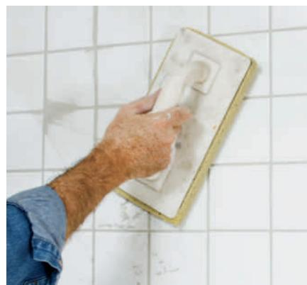
**3 Fjern overflødig fugemasse** med en flissvamp når det er gått et kvarters tid. Skyll svampe ofte og press ut det meste av vannet for hver gang.
