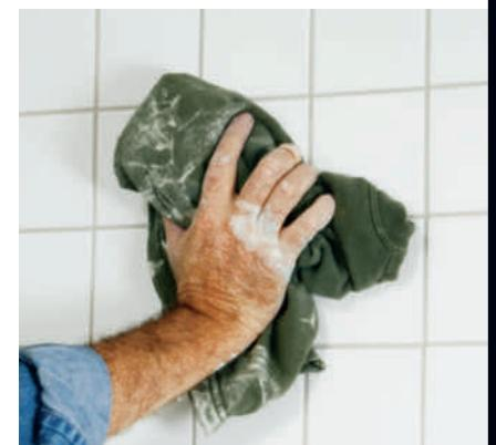
**4 Poler flisene med en tørr bomullsklutt** etter en halvtimes tørketid. Tørk vannrett og loddrett, så fugene blir glatte.
