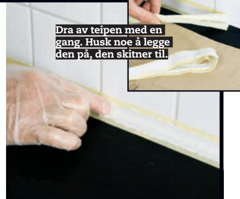
**3 Trykk pekefingeren mot fugen** og glatt den ut i pen bue. Den overflødige fugemassen havner på teipen.
