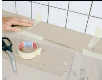
**1 Sett bølgepapp i den nederste fugen.** Fugen skal fylles med silikon senere. For å unngå at den blir fylt med fugemasse, er det lurt å beskytte den med for eksempel bølgepapp.
