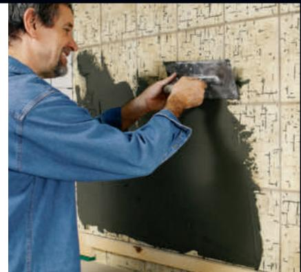
**1 Kloss opp en jevn høvlet list.** Den skal sitte i vater, og overkanten skal være i andre flisrekkes underkant. Det vil si høyden på nederste flis pluss to fugebredder (under og over nederste flis).
