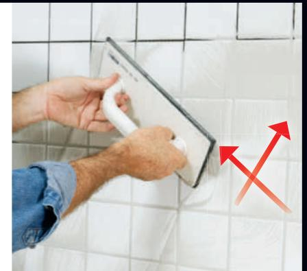
**2 Press fugemassen inn i fugene.** Bruk et gummibrett og jobb diagonalt på fugene, slik at alle fuger blir fylt helt opp. La fugemassen tørke et kvarters tid før du fortsetter.
