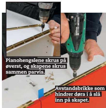
3 Montér pianohengsler på toppen av alle fire skapene. Når dørene er malt, holdes de mot skapet mens de skrus fast gjennom pianohengslene. La det bli 1–2 mm luft mellom dør og skap.
