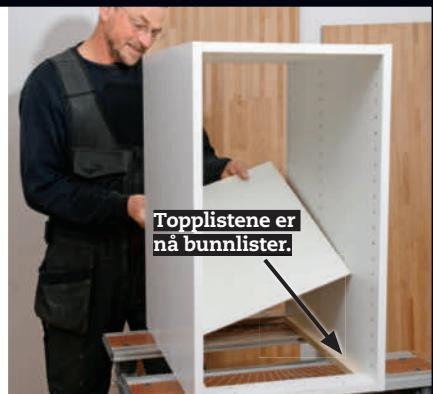
**2 Snu skapet på hodet,** og skjær til bakplata slik at den kan legges inn i skapet som bunn, og stift den på.
