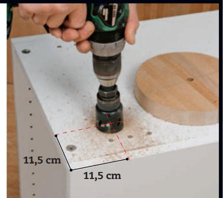
**2** Bor ut på toppen av det ene skapet til den gjennomgående skruen. Lag et hull på min. 30 mm med ei hullsag slik at det er plass til mutteren. Sentrum skal være i krysset 11,5 cm fra hver side.
