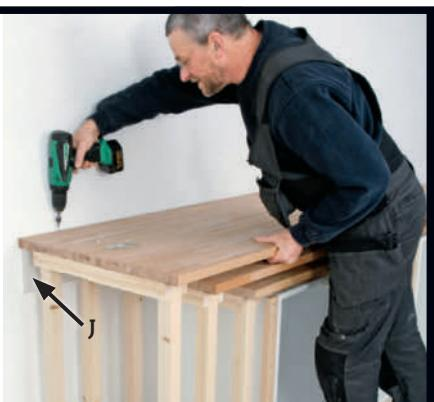
**3** Den øverste plata skrus fast til støtteplata (J) fordi den ikke skal kunne svinges ut. Skru først fast beina på platene, og sett filtnotter under.
