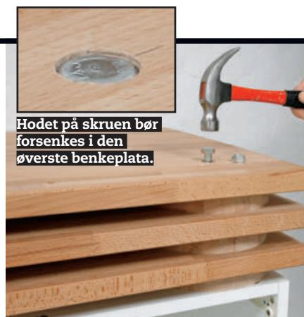
**2** Bank en 12 x 180 mm skrue gjennom hullene når du har lagt de tre benkeplatene med rundinger på plass, og spenn på en mutter nedenfra.
