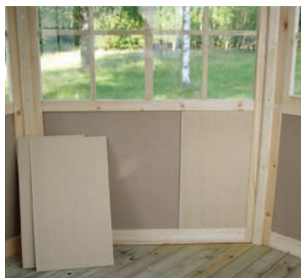
Når den ytre dekklista er oppe, skrues lista på innsiden fast til den slik at begge lukker mellomrommet.
