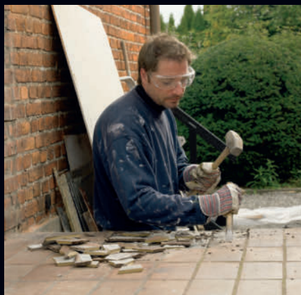
■ Plattor och skärmtak tas bort
