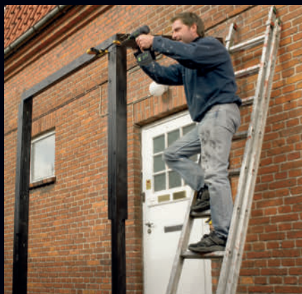
■ Den nya stommen monteras
