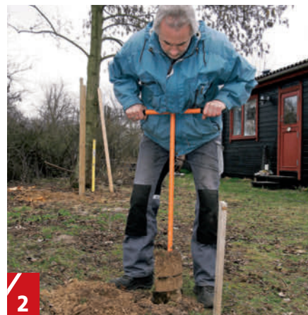
2 Hålen till de första hörnstolparna (A) borrar med jordborr för ett par hundralappar. Borren är snabbt nere på 100 cm djup och det styrker gänget i tron på att de klarar att bygga med enkla medel och handkraft.
