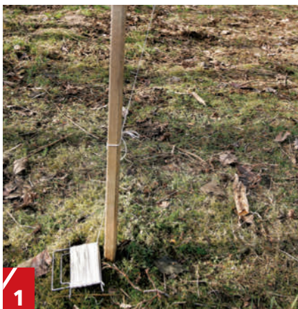
1 Först markeras fasadens placering med två käppar och lina mellan dem. Här är det viktigt att lina hamnar parallellt med fasaden på sommarstugan, som står precis intill.
