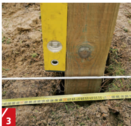
3 När nästa stolpe sätts på plats skall de två stolparna stå parallellt med stugan (det markerar lina). De skall stå på rätt avstånd från varandra och de skall vara lodräta. De skall dessutom vara lika höga.
