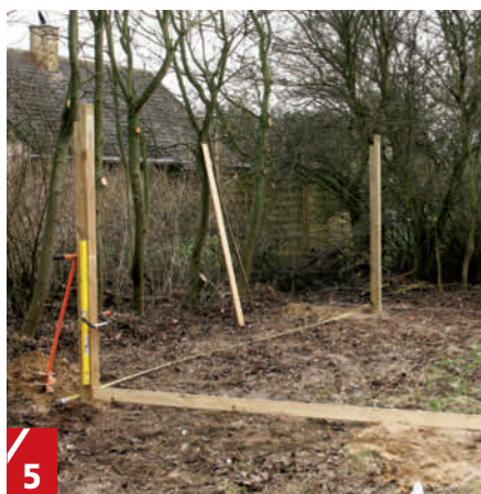
5 Nu kan den tredje och fjärde hörnstolpen sättas. Den tredje sätts 210 cm längs den lina som markerar gaveln. Den fjärde sätts 580 cm från den tredje stolpen och 210 cm från den första. Måtten tas längs stolparnas utsida.
