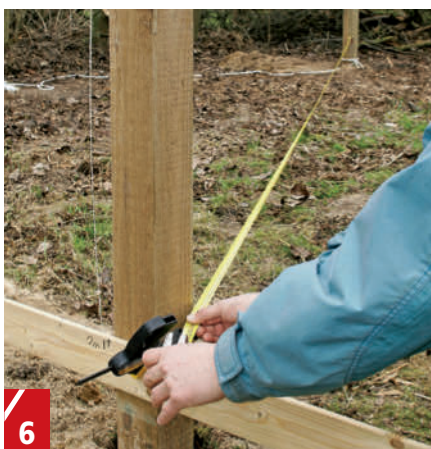
6 Till sist kontrolleras att diagonalmåttet mellan de två paren hörnstolpar är exakt lika stora för annars blir carporten skev! De fyra sista stolparna placeras på långsidorna. Två på varje långsida.
