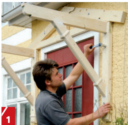
1 Konsoler och takstol sätts fast med franska träskruvar. Se till att de verkligen får fäste i väggen (alternativt pluggarna, om det fasaden är av tegel eller är putsad).
