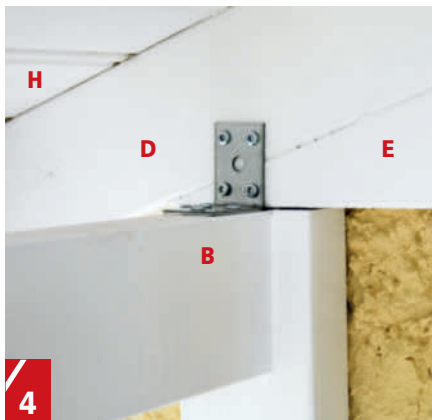
4 Bägge takstolarna fästs på konsolerna med vinkelbeslag, 35 x 50 x 50 mm, och det går åt fyra beslag. Takstolen som sitter mot väggen fästs med franska träskruvar i väggen.
