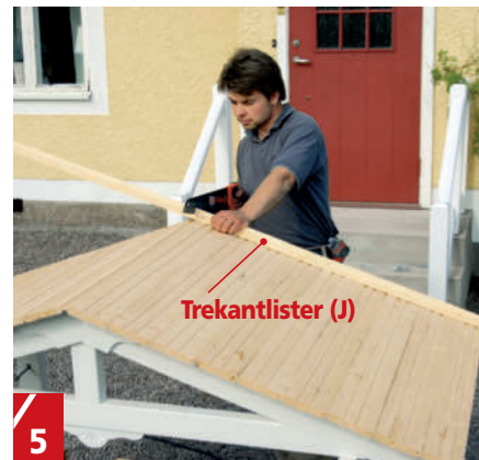
5 Hela taket tas ner en gång till så att vi kan fästa resen av brädorna och trekantlister (J) innan takpappen läggs. Hade vi haft mera arbetsplats ovanför taket hade vi inte behövt ta ner det för detta jobb.
