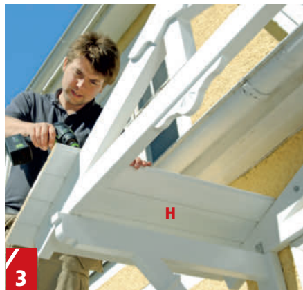
3 Pärlsponten (H) är notad och spontad och fästs med profilen neråt. Vi använder trallskruv som försänker sig själva. Då blir det lättare att lägga takpapp. Den nedersta brädan sticker ut för att passa till takfotsbrädan.
