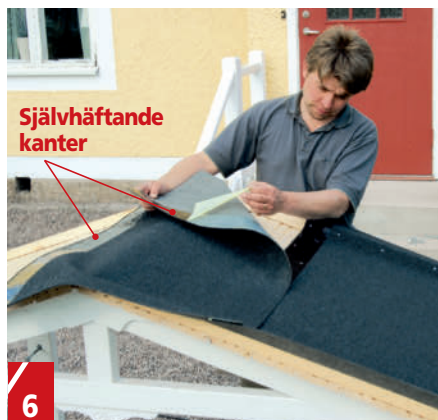
6 Takpappsbitar skärs till. Takpappen har en självhäftande kant. Börja nerifrån med den självhäftande kanten och fäst upptill med pappspik. Lagg nästa våd med överlappning. Lagg på andra sidan och till sist övernocken.
