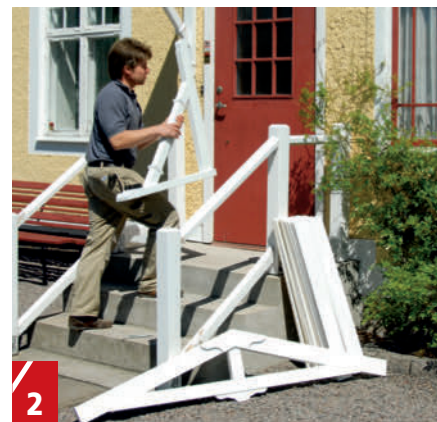
2 Måla delarna innan de sätts fast. Försegla alla kvistar med shellack så att de inte tränger igenom färgen. Här stryks allt trä med olja, grundfärg och heltäckande vit utelasyr. När färgen har torkat sätts taket på plats.
