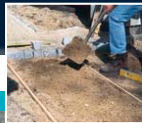
Asennushiekka levitetään kantavalle murskeelle.
