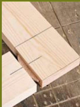
Suorakulmainen kulmaliitos, johon lamelli on mahdutettu tarkasti.
