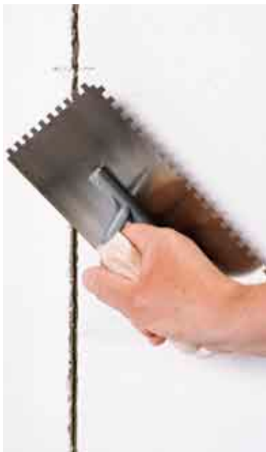
Tässä laatoitetaan kevytbetonielementtiä. Ensin alustan pinta kaavitaan aivan tasaiseksi teräslastalla.
