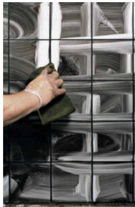
Mustalla saamaaminen näyttää hurjalta, mutta jäljestä tulee upea. Saumaus- aineen saa pestyä helposti pois laatoista.
