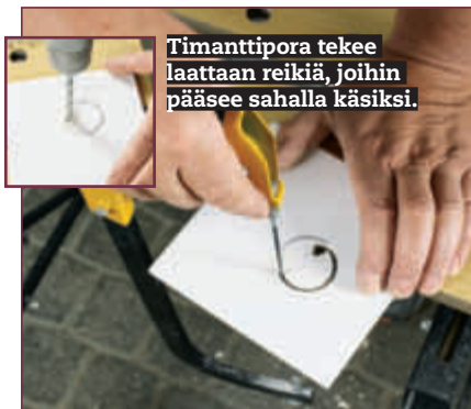
Merkittyy aukkoon lyödään reikä lasitukseen, josta päästään vähitellen käsiksi itse laattaan.
