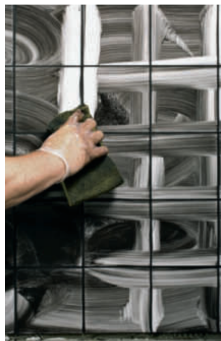
Det ser smutsigt och kladdigt ut när vi fogar med svart fogbruk, men det går lätt att tvätta bort resterna efteråt.
