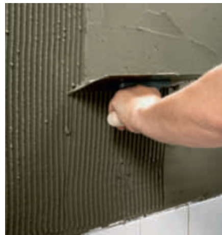
När kakelfixet lagts på dras det ut med en tandspackel. Dra nerifrån och uppåt. Håll spackeln nästan vågrätt.
