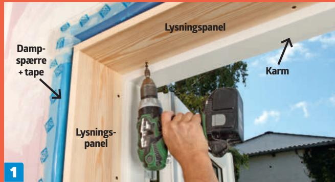
**Lysningspanelerne sættes forsigtigt på plads** uden at beskadige dampspærren unødig. Pres lysningspanelerne mod karmen, mens du skruer dem foreløbigt fast med 35 mm gipspladeskruer. Skruerne er spidse og borer sig gennem båndstålet bag lysningspanelet.
