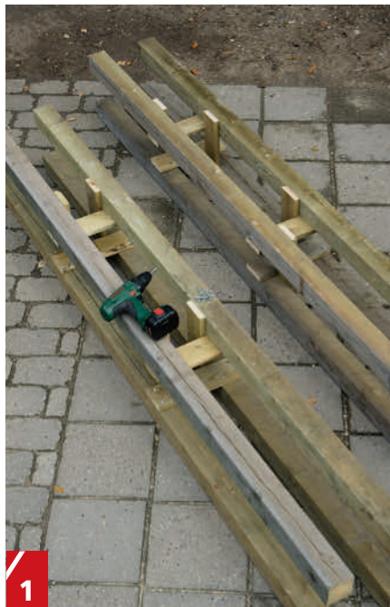
1 Sätt ihop reglarna till stolpar med 30 cm långa brädlappar (B). Fäst dem med 5 x 60 mm skruvar.
