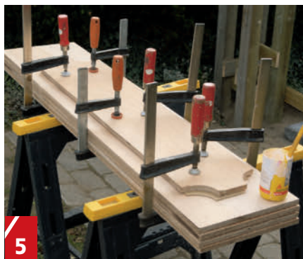
5 Stryk lim på baksidan av masonitskiivorna och limma dem på frontskiivorna (C). Spänn ihop alla skivor på en gång med tvingar och låt dem sitta i press tills limmet har hårdnat.
