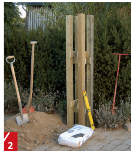
2 Gräv håll för stolparna. Hålen bör vara minst 80 cm djupa. Använd spade eller jordbör. Blanda grovt grus och småstenar med en påse torrbetong (se förpackningen).
