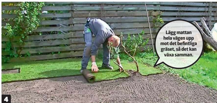
4 Rolla ut gräsrullarna. De utrullade mattorna ska läggas helt kant i kant, och i förband.
