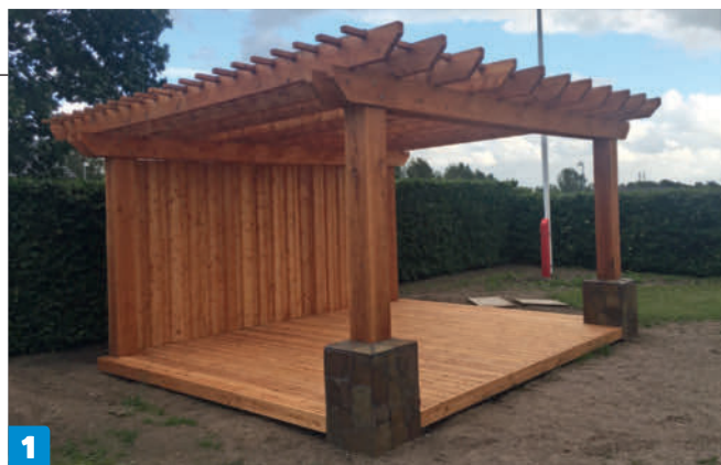
1 Vägghpanelen baktill på övertäckningen monteras. Brädorna sätts upp en på två på tvärgående regler som fästs mellan stolparna längst bak.
