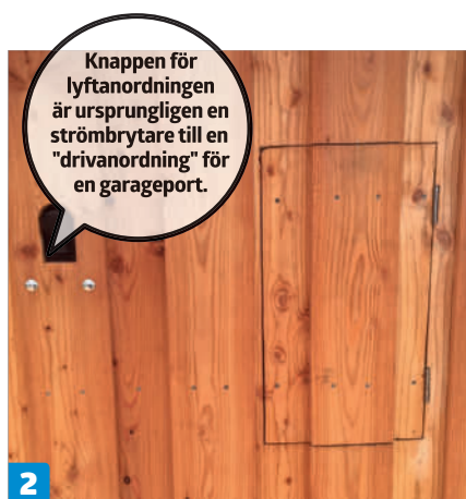
2 Hål för en lucka sågas i panelen. Luckan fästs med pianogångjärn. Hålet sågas ut med en sticksåg. Vid sidan sågas ett mindre hål för knappen som aktiverar lyftanordningen till den runda plattan med ölen.
