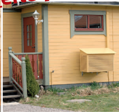
Pumpen har byggts in i en liten låda med liggande lameller som har målats med samma färg som huset.
