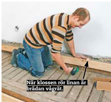
Den ena linan ser till att första brädan sitter vågrät.
