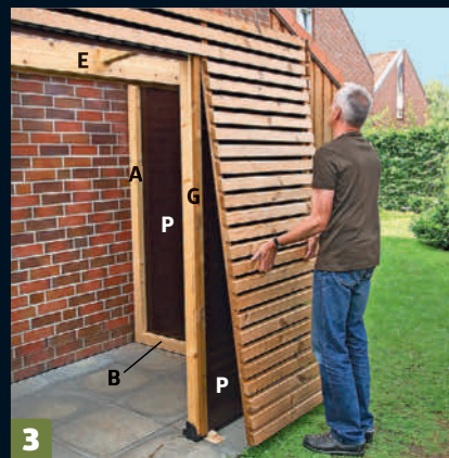
3 Ruuvaa elementit kiinni. Asenna aluksi kolme pitkää rimaa (K1) seinän yläreunaan. Asenna nyt rimaelementti oven oikealle puolelle.
