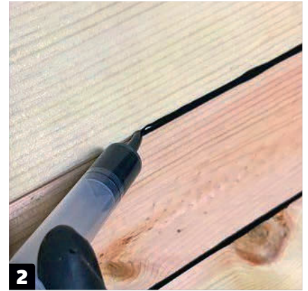
2 Levitä epoksi ruiskulla ja täytä sauvojen väliset raot kokonaan. Ole varovainen, jotta epoksia ei kulu liikaa.
