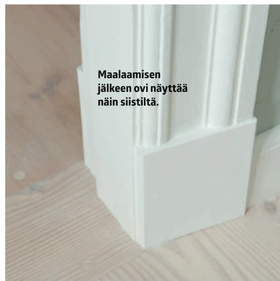
5 Kiinnitä karminpätäkät (H) liimalla ja ruuveilla. Upota ruuvien kannat pinnan alle. Peitä ruuvinkannat ja liitokset tasoitteella ja hio pinta hiomapaperilla.
