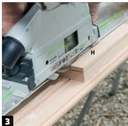
3 Sahaa lankusta pätäkät, jotka ovat tarkasti yhtä pitkät kuin irti sahatut palaset. Tee lankkuun huullos upotussahalla. Se on helpompaa kuin yläjyrsimen käyttäminen.
