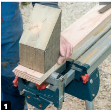
1 Sahaa tolpasta pätäk 45 asteen kulmassa. Pätettä käytetään ohjaimena karmin (G) sahaamisessa.
