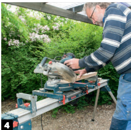
4 Sahaa uusien karminpätkien päät poikki 45 asteen kulmassa. Muista sahata kulmat oikeassa suunnassa, jotta osat sopivat karmeihin.
