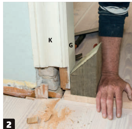
2 Sahaa pystykarmit (G) poikki ja merkitse, kummalle puolelle ovea pätäkät kuuluvat. Sahaa peitelistat (K) poikki vaakasuorassa.
