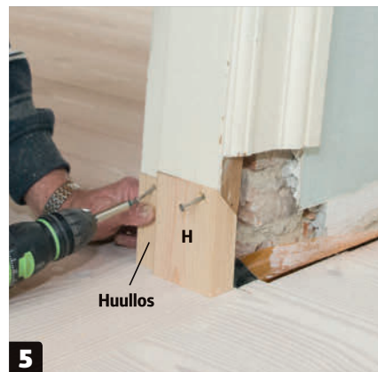
5 Kiinnitä karminpätäkät (H) liimalla ja ruuveilla. Upota ruuvien kannat pinnan alle. Peitä ruuvinkannat ja liitokset tasoitteella ja hio pinta hiomapaperilla.
