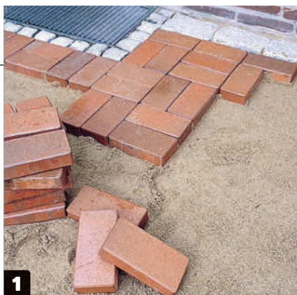
1 Aloita pihatiiltien asentaminen kellarin ikkunan ympäriltä. Tämän pihatieen tiilet asennetaan pareittain vuorotellen eri suuntiin.
