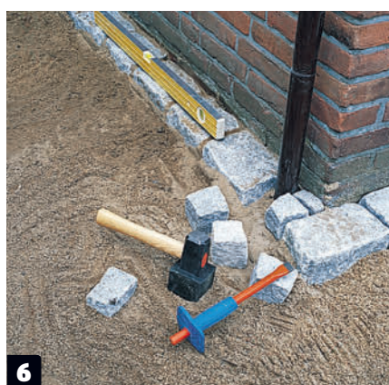
6 Lohko kivet sopiviksi paloiksi vasaralla ja lyöntimeisselillä. Asettele pienet kivenpalat syöksytorven ympärille mahdollisimman siististi.
