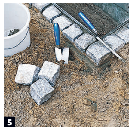
5 Asenna noppakivet kellarin ikkunan ympärille ja peitä syvennys ritilällä. Nämä noppakivet tuetaan pienellä betonivalulla. Sekoita betoni suhteessa 1 osa sementtiä ja 5 osaa hiekkaa.
