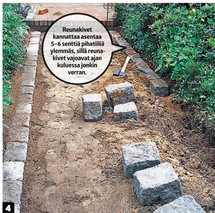
4 Viritä tien toiseen reunaan linjalanka ja asenna loput reunakivet. Tasoita asennushiekka ja tee siihen 1–2 sentin kaato metriä kohti. Varmista, että tie kallistuu oikeaan suuntaan.
