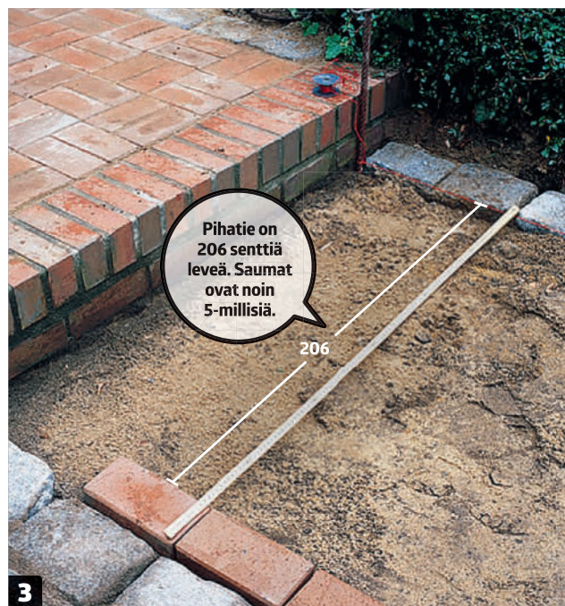
3 Tarkista, että tielle mahtuu niin monta tiiltä kuin suunnittelit. Reunimmaisista kiviä ei kannata leikata kulmahiomakoneella. Tee tiestä niin leveä, että kaikki tiilet mahtuvat paikalleen kokonaisina.
