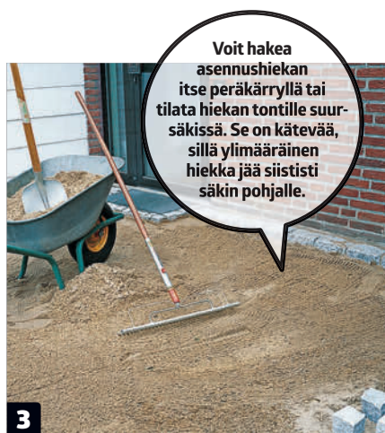
3 Levitä murskeen päälle 2–4 sentin kerros asennushiekkaa. Tasoita hiekka haravalla. Asennushiekkan jyväköön pitää olla noin 0–4 millia.
