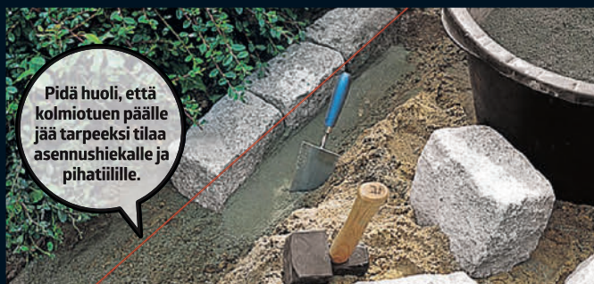
4 Viritä tien toiseen reunaan linjalanka ja asenna loput reunakivet. Tasoita asennushiekka ja tee siihen 1–2 sentin kaato metriä kohti. Varmista, että tie kallistuu oikeaan suuntaan.
