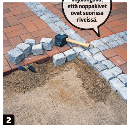
2 Lado noppakivet paririviin ristin muotoon ja jatka pihatiiltien asentamista. Ristin pitää olla suorakulmainen, jotta tiilikuvio pysyy symmetrisenä.
