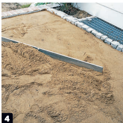
4 Tasoita hiekka linjalaudalla tai suoralla laudalla. Pinnan pitää kallistua 1–2 senttiä metrin matkalla, jotta vesi valuu pois talon suunnasta.
