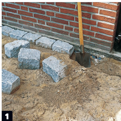
1 Kaiva kouru reunakiville. Tässä reunakivet asennetaan samaan tasoon talon sokkelin kanssa.
