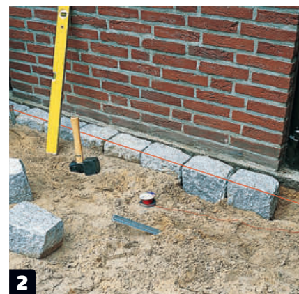
2 Koputa reunakivet kiinni hiekkaan kumivasaralla. Varmista linjalangalla ja vatupassilla, että kivet ovat suorassa linjassa ja yhtä korkealla.
