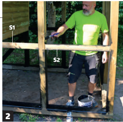
2 Maalaa runko. Se on helppoa tehdä ennen kanaverkon asentamista. Kanaverkon päälle asennetaan myöhemmin peitelaudat, joten rungon ulkopuolta ei tarvitse maalata.
