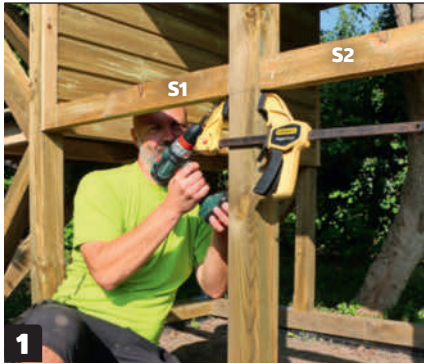
1 Asenna poikkilankut (S1, S2 ja S3) 5x100 millin ruuveilla. Lankkuja tarvitaan kanaverkon kiinnitysalustaksi.
