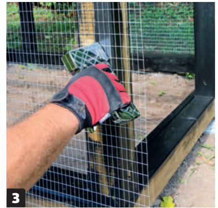
3 Leikkaa kanaverkosta sopivat palaset. Se on helppoa peltisaksilla. Verkko kannattaa asentaa myös kanalan kattoon, jos lähimetsissä on näätä.
