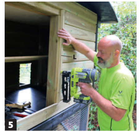
5 Asenna rima (L) oviaukon oikeaan reunaan luukun paikalle. Sahaa aukon alareunassa oleva pontti pois pistosahalla.
