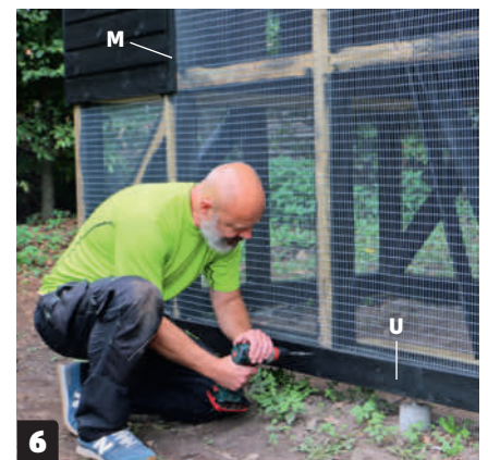
6 Asenna valmiiksi maalatut peitelaudat (U) kaikkiin paikkoihin, joissa verkko yltyä rungon päälle.
