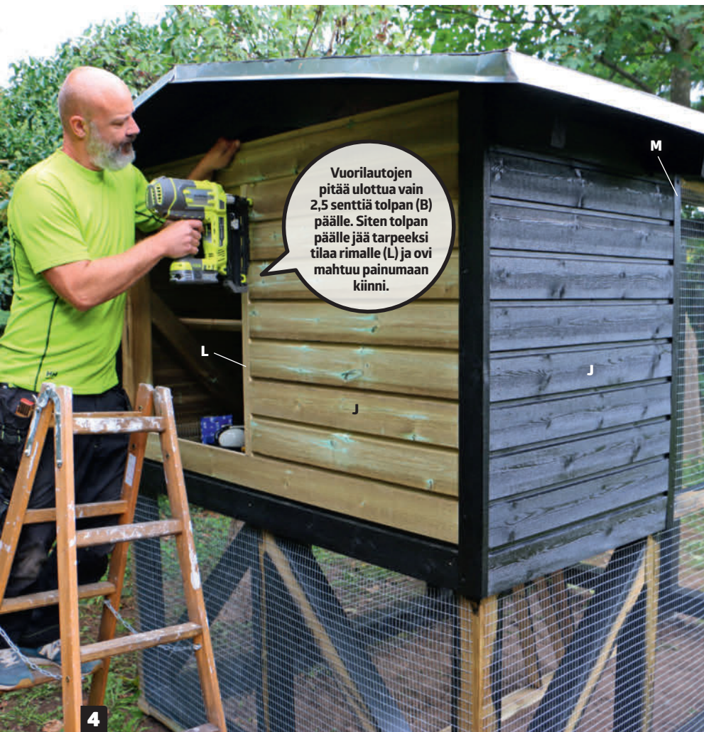
4 Asenna loput vuorilaudat (J ja M). Maalaa verkkoa vasten asennettavat laudat ennen asentamista. Viimeiset laudat kannattaa asentaa vasta tässä vaiheessa, jotta ne peittävät kanaverkon reunan. Siten lopputulos näyttää mahdollisimman siistiltä.
